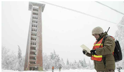
Nacionālo bruņoto spēku karavīri veic sagatavošanās darbus, lai demontētu bīstamo Gaiziņkalna skatu torni, 2012. gada 14. decembris
